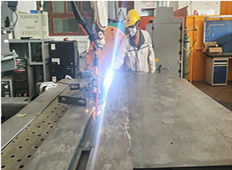
图 6 侧墙蒙皮拼接装配压紧工装
